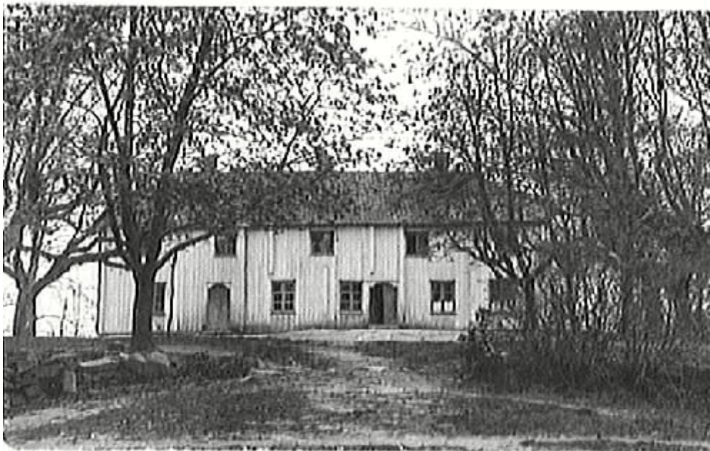
Mansgårdsbyggnaden på Tranebergs gård. Fram till 1908 var Tranebergs skola inrymd i huset. Lärarinna hette Lovisa Dahlén, hon var sk "självlärd". När den nya skolan togs i bruk 1908 stod huset obebott med ett undantag. I lägenheten till höger om stora ingången bodde trädgårdsmästaren Edvin Flykt till i slutet av 1920, han arrenderade trädgården på Traneberg. Gunnar Andersson blev ägare till gården i slutet på 1920-talet och bodde först i en flygelbyggnad. Ombyggnaden av stora huset skedde i början av 1930-talet. Även Emil Ryd, en tidigare ägare till gården hade bostad i en flygelbyggnad. (Avfoto av ett vykort)
